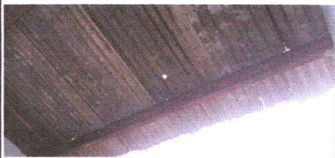
Foto 3: Mantenimiento a estructura de soporte de metal
